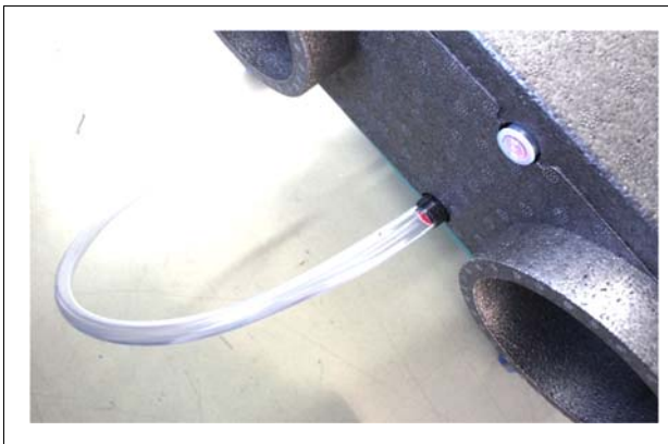
Abb. 4.5 Installation Kondensatschlauch
